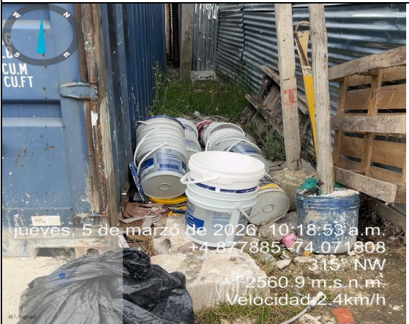
Fotografía 5 Canecas de pintura sin lavar dispuestas en suelo sin aislamiento, mezclado con trozos de ladrillo.
